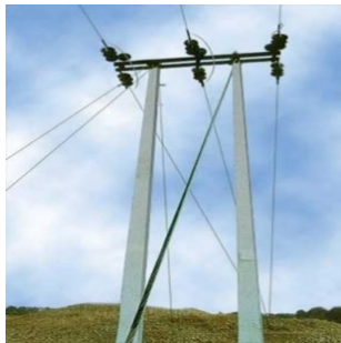
Şək.20. Dəmir-beton dayaq.
